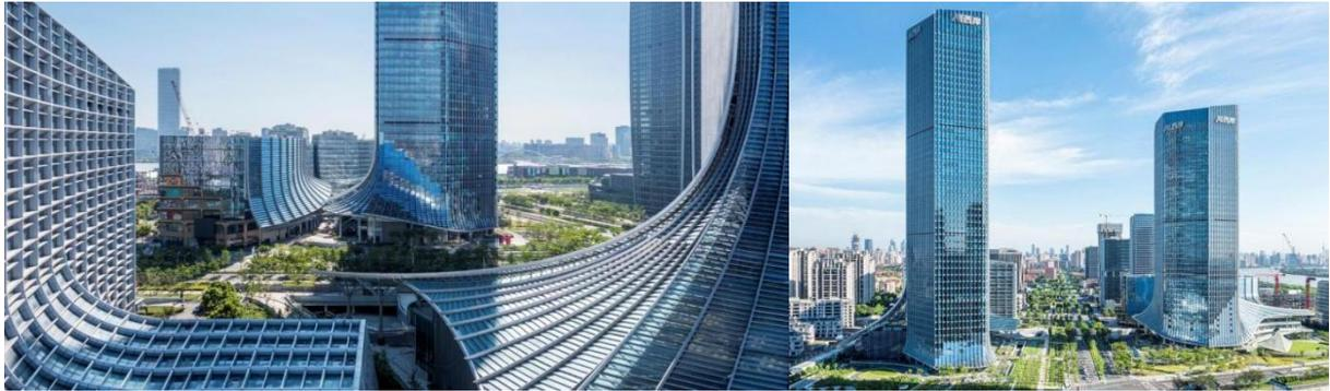
AI TOWER 是一组最大标高达 236.59 米的超高层建筑，由(日本)株式会社日建设计担纲概念设计，上海建筑设计研究院有限公司(隶属华建集团)为代表的华建集团设计服务团队打磨，一造科技联合谢亿民科技参与部分幕墙和整体裙摆系统的设计深化，并承担相关施工方案优化和数字建造。通过建筑结构性性能化设计技术，一造科技将幕墙系统原有设计优化至近乎极致的科学、美观、安全，并在设计优化阶段即统筹考虑数字建造的运用需求;而后以机器人建造工艺为核心，协同施工单位，综合应用钢构件预制、现场定位与焊接、幕墙安装等工序，“多快好省”地落地优化方案，实现了此次地标性超高层建筑的数字设计与智能建造任务。一造科技通过独创的数字设计和建造模式，结合 AI 技术的应用，与合作伙伴们一起以可控的资源投入，高效、环保而有品质地打造出 AITOWER 这座“竖立的硅谷”，为上海西岸徐汇滨江的人工智能高地带来又一座全新地标，助力上海乃至长三角地区构建支撑产业智能化发展的全新生态。
