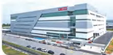
通富 AMD 马来西亚槟城先进封装洁净室项目
