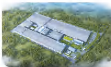
冠宇马来西亚新能源建设工程项目
