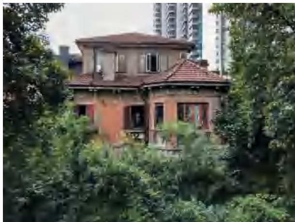
花园住宅（修缮前）
