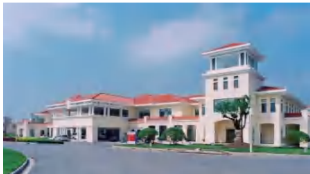
▲公共卫生临床中心
