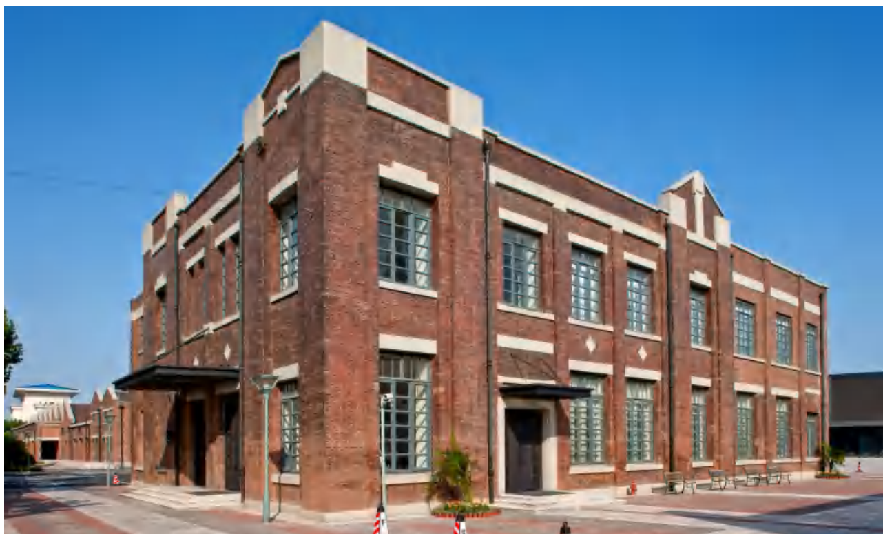
改造后的 1 号楼会所 / clubhouse
