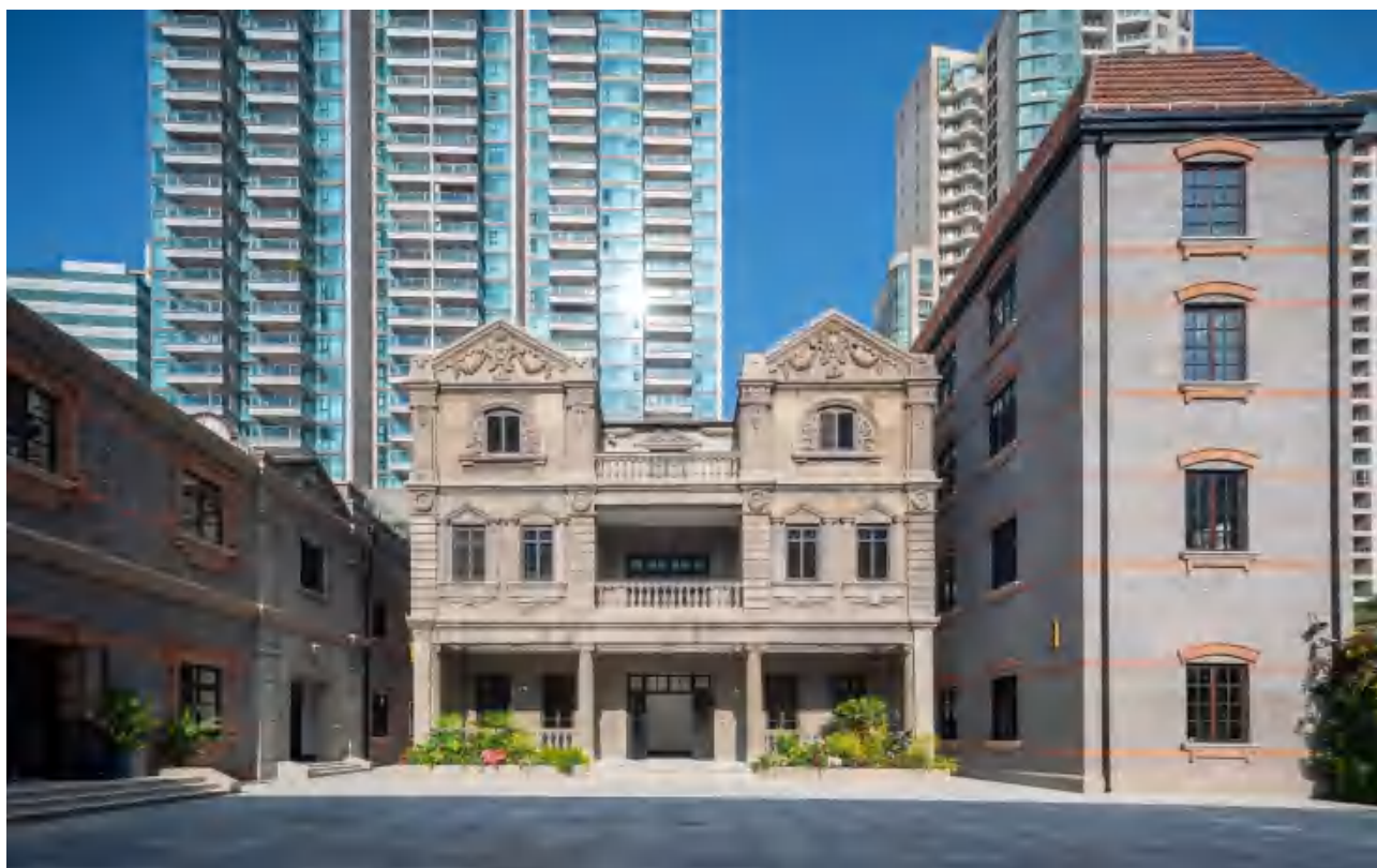
花园住宅修缮后立面
