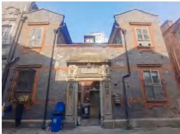
后期石库门里弄（修缮前）
