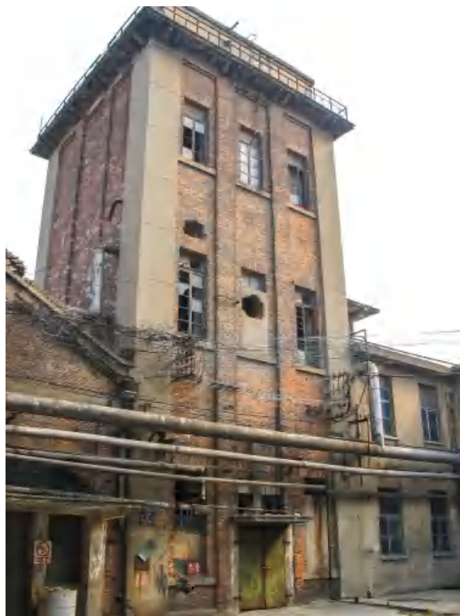
左图 1：1 号楼改造前； 左图 2：3 号楼改造前； 左图 3：3 号楼室内改造前； 右图：2 号楼改造前
