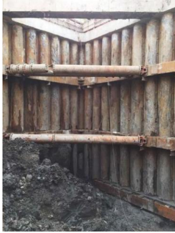
图 1 典型深厚软土地基组合钢管结构连续墙施工现场开挖图
