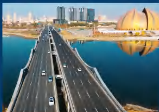
新疆昌吉吉昌大道 跨头屯河大桥新建工程
