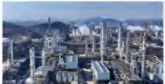
万华化学乙烯项目二期120万吨/年乙烯装置 惠生百万吨成套乙烯技术大规模商业化应用
