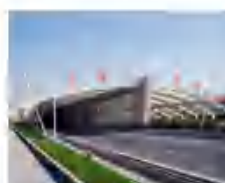
崇明通道长江隧道工程
