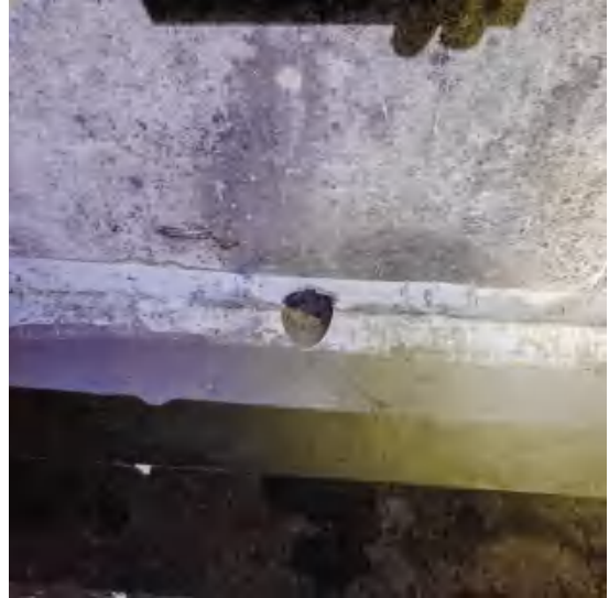
现场运用照片 4: 成孔与护壁作业图
