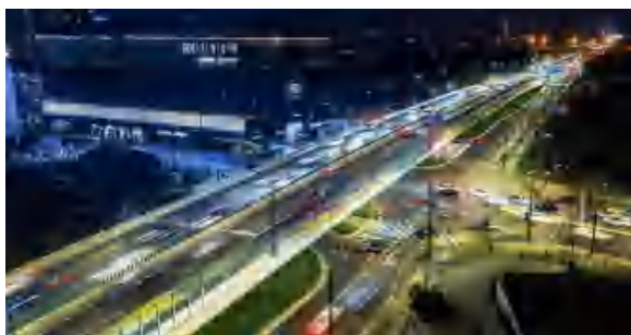
杨高路芳甸路立交改建工程，2020年
