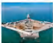
深中通道海底沉管隧道
