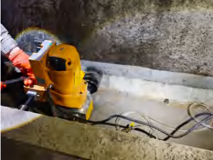
现场运用照片 3: 钻孔施工过程视频
