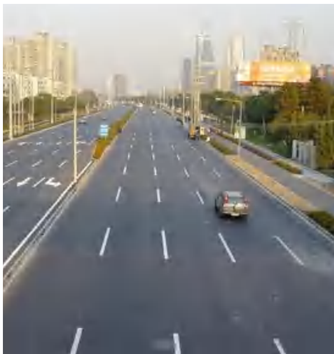
杨高路（成山路-外高桥5号门）路段整治效果，2008年
