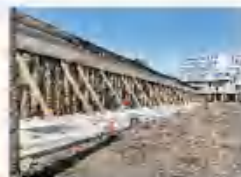
上海临港某新工项目
