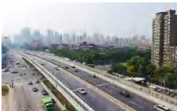
杨高路民生路立交工程建成通车，2015年
