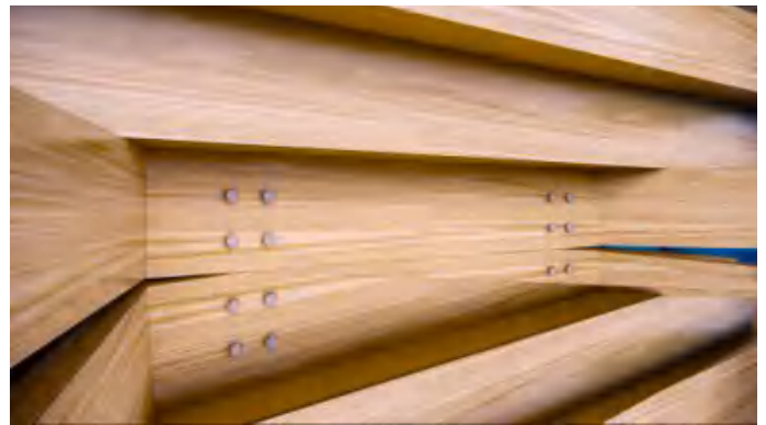
11 “设计之构” 基座连接件细部
