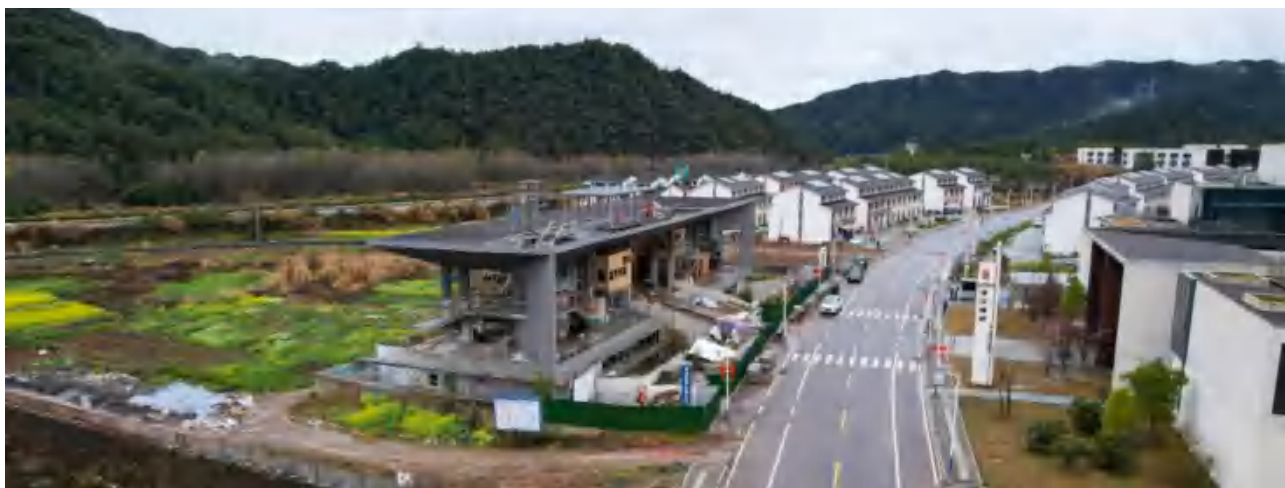
15 西湖会客厅 现状施工照片
