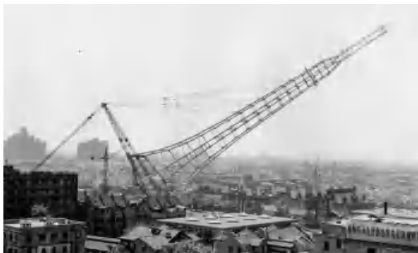
▲整体起扳塔体
