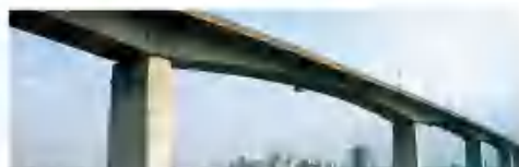
“桥梁造型美观、技术指标先进”的奉浦大桥
