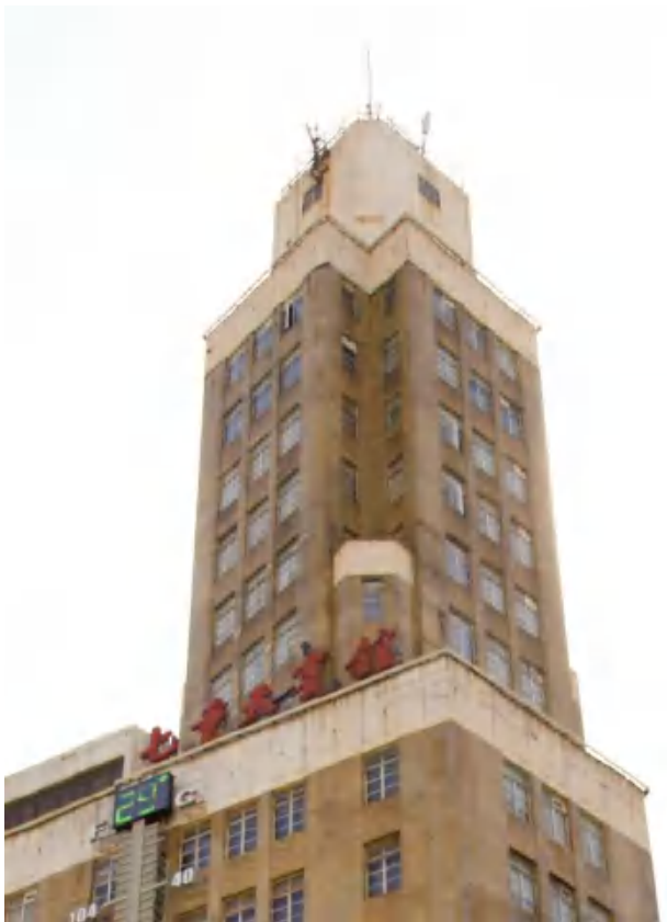
▲楼顶发射天线
