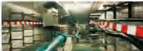
张杨路共同沟——全国第一条综合管廊
