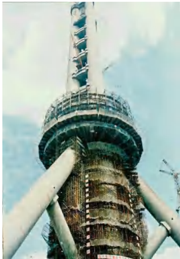
▲东方明珠施工
