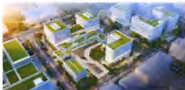
上海申昆路地下停车场及上盖综合开发
